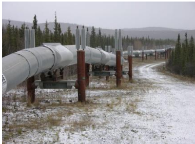
Afb. 6 – Oliepijpleiding in Alaska
